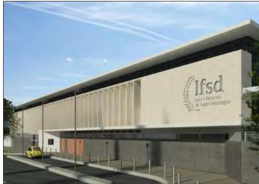
ADECUACIÓN Y REMODELACIÓN DE LA PLANTA FÍSICA DEL LICEO FRANCES DE SANTO DOMINGO. 2017
