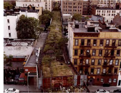
14 Línea férrea a finales del siglo XX.
