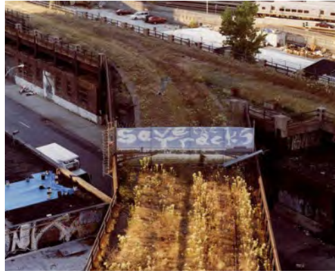
13 Líneas férreas a finales del siglo XX.
