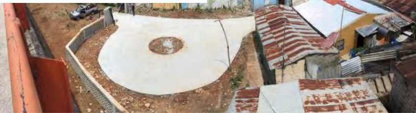
Demolición y adecuación Barquita Norte 100% ejecutado
